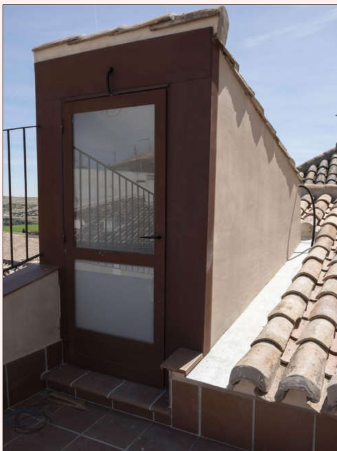
Adecuación de la planta cuarta.
