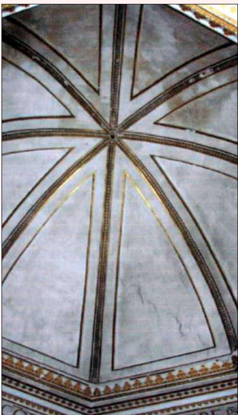
Capilla del palacio de Fernando de la Cerda: detalle de la plementería.
