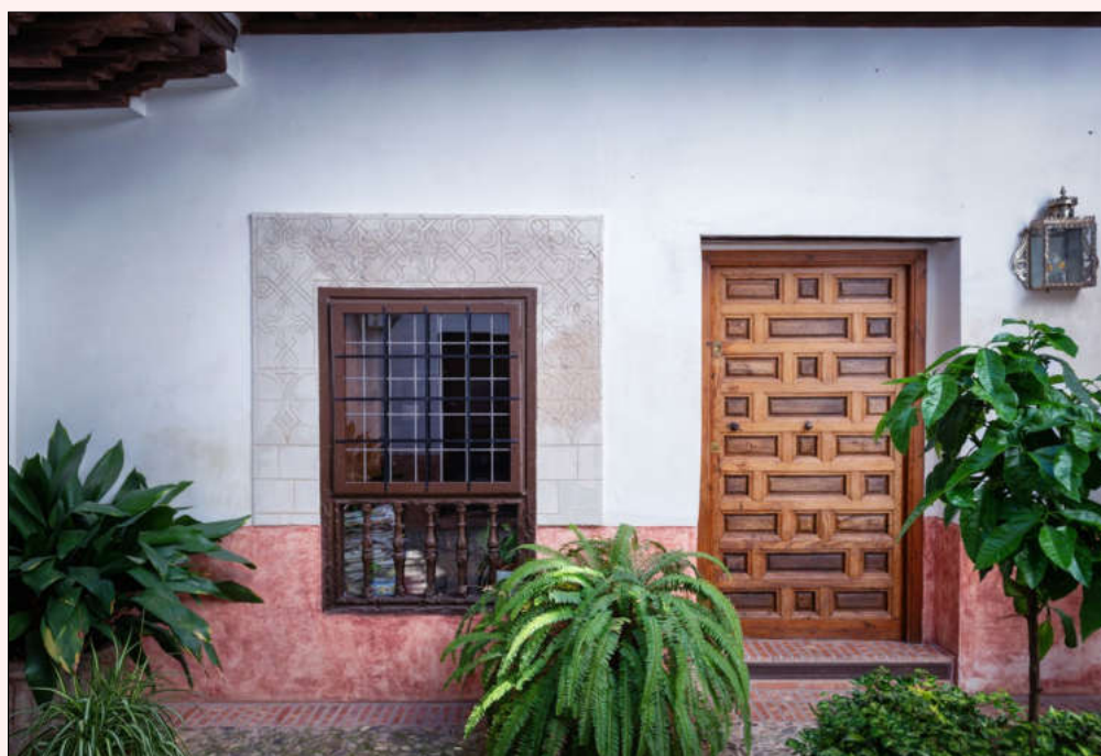
Detalle del patio de calle San Bartolomé, 4.
