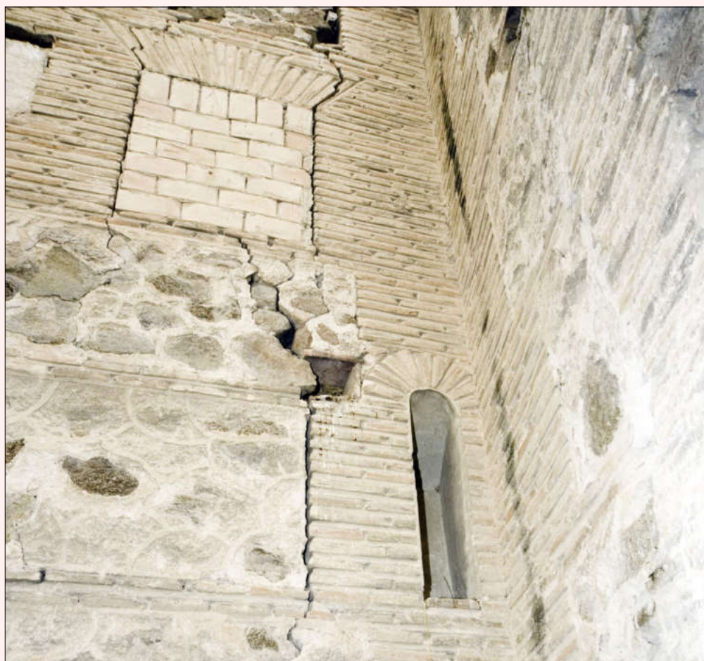
El proyecto para las Jerónimas incluye tareas de consolidación y saneamiento de los muros.
