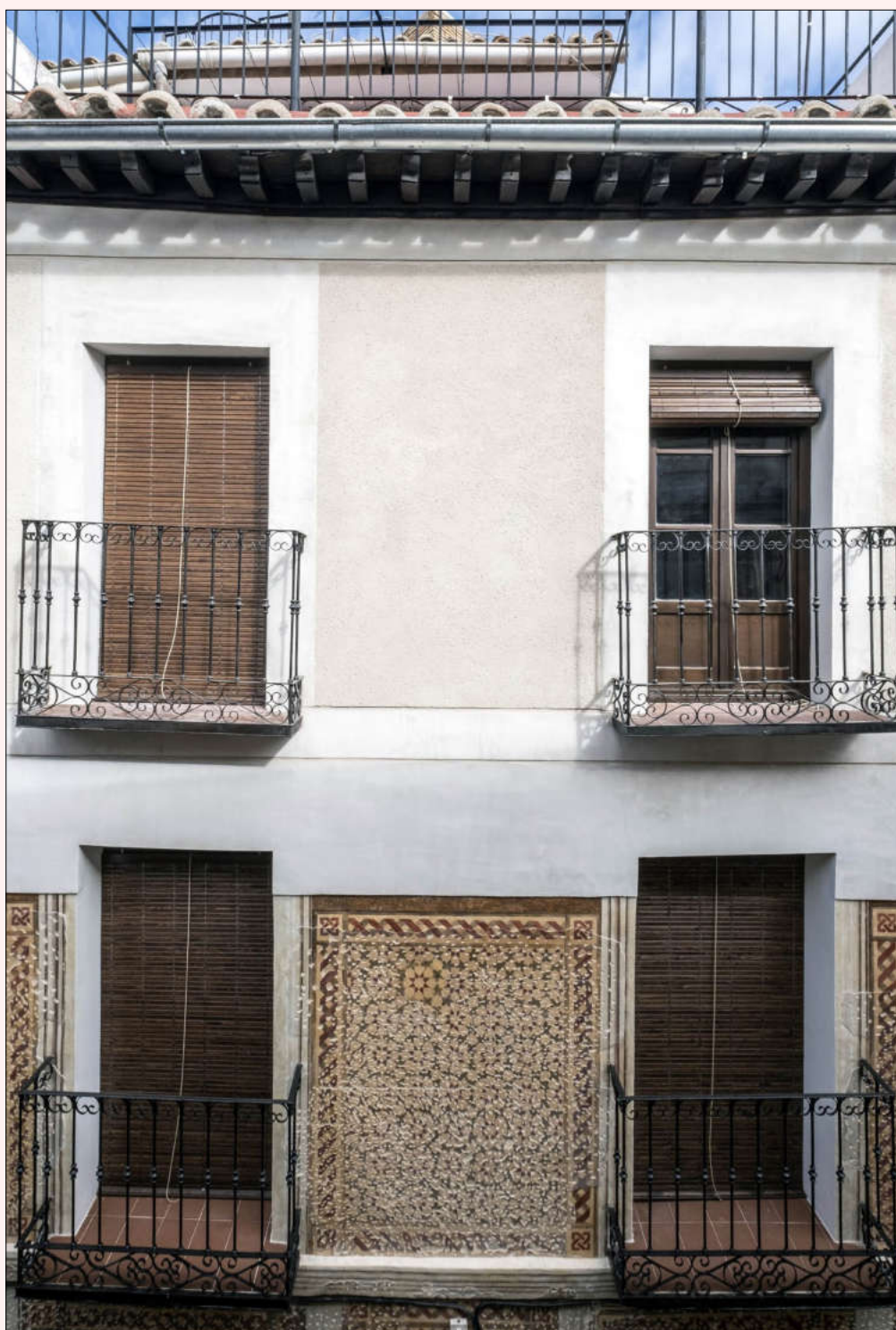
Hombre de Palo, 5: detalle de los diseños geométricos de la fachada, de inspiración andalusí.
