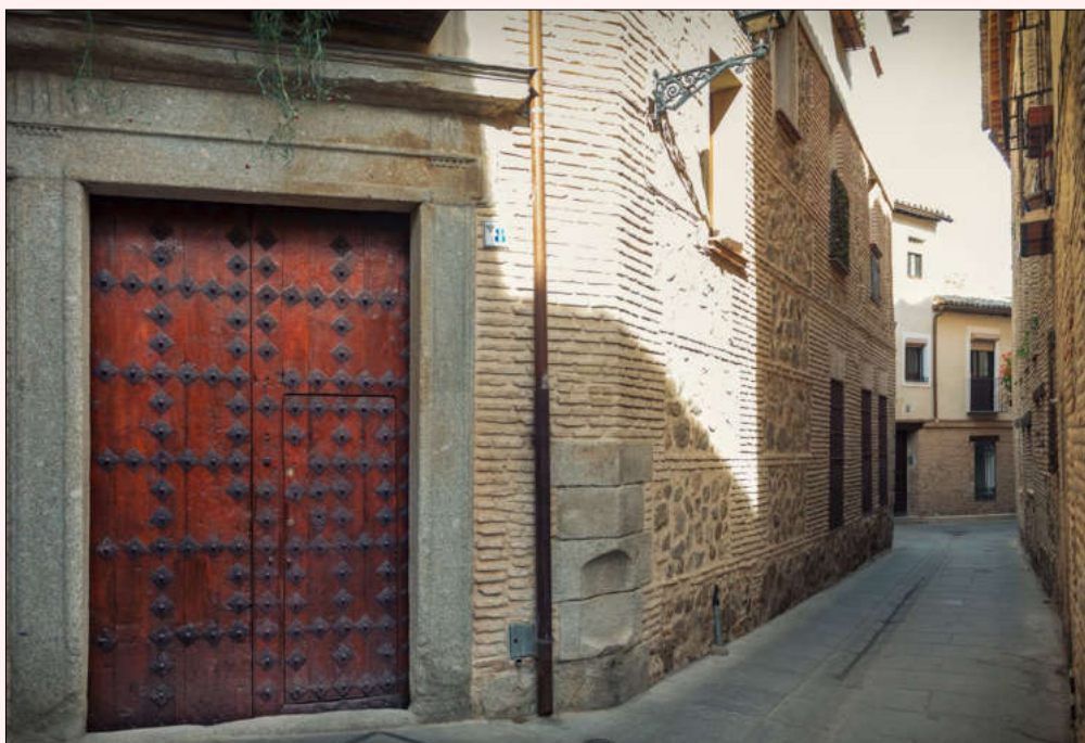
Yesería y portada exterior de la calle de las Bulas, 8.
