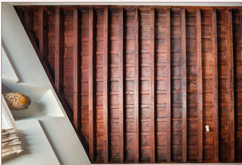
Armadura de madera y alfarje en C./ Retama, 12.
