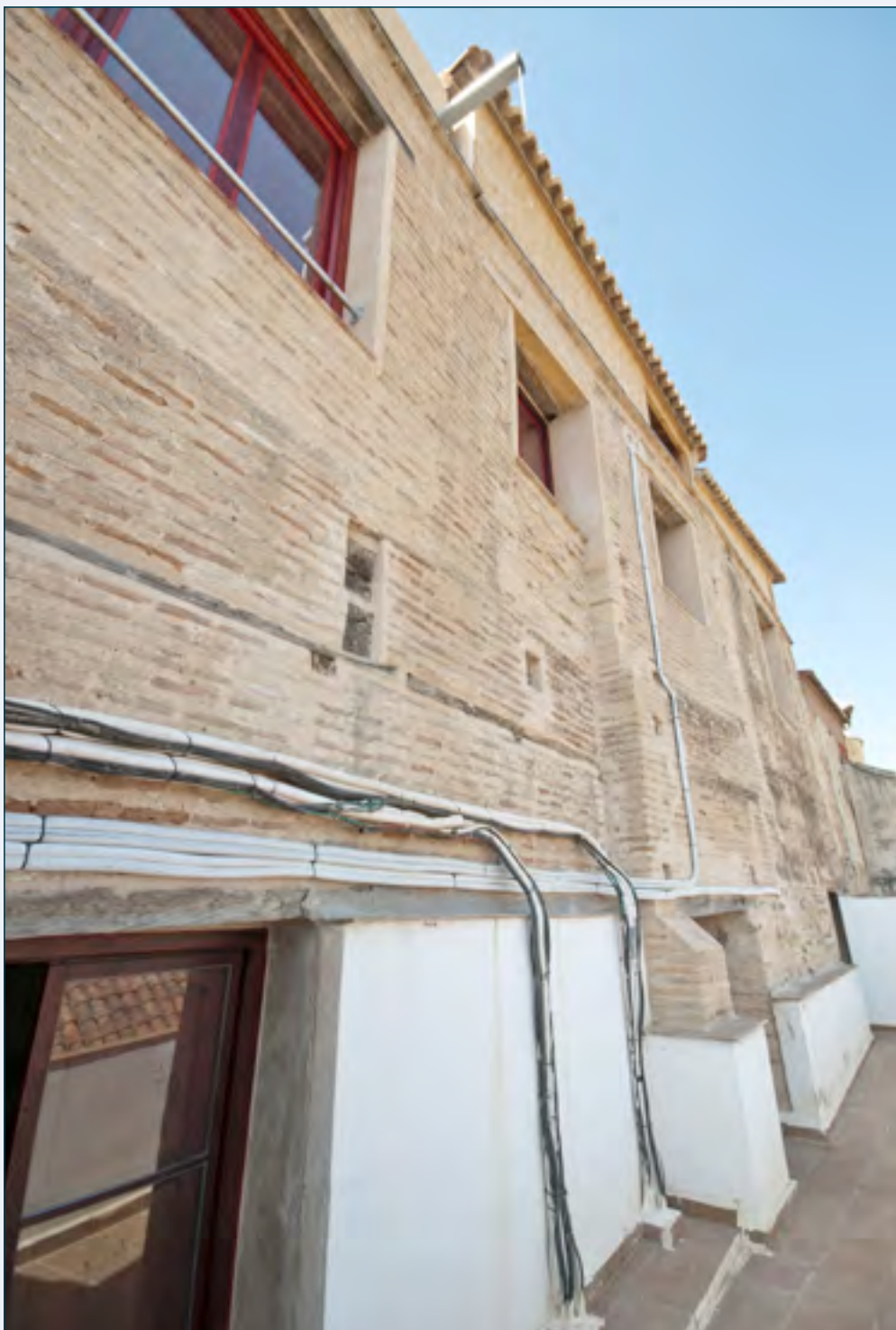
Rehabilitación Callejón de Menores, 12 (Fase II)
