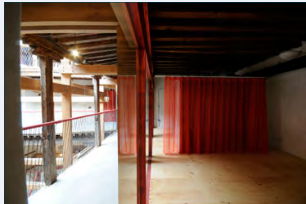
Trabajos de rehabilitación en el Callejón de menores, 12 (Fase III)
