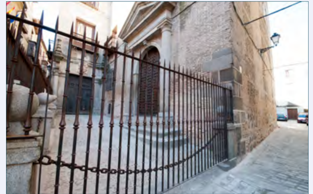
Capilla de San José con la Cámara Bufo terminada
