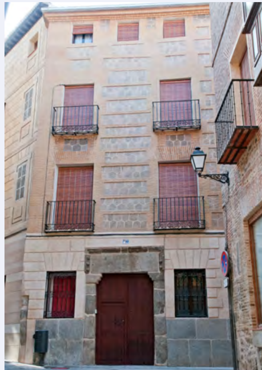
Fachadas Calle La Plata
