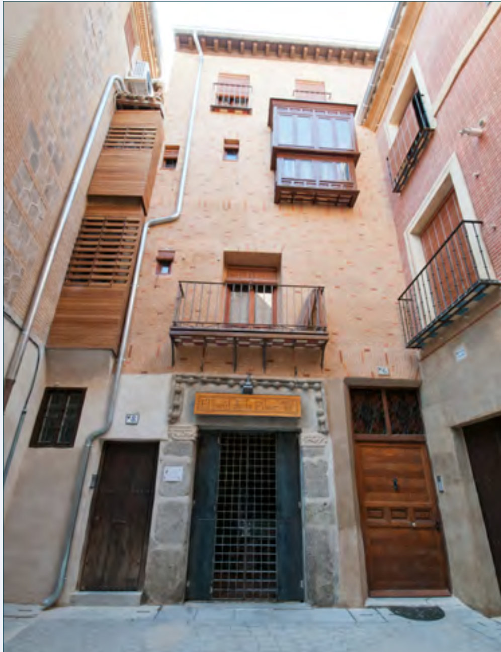
Fachada Calle La Plata
