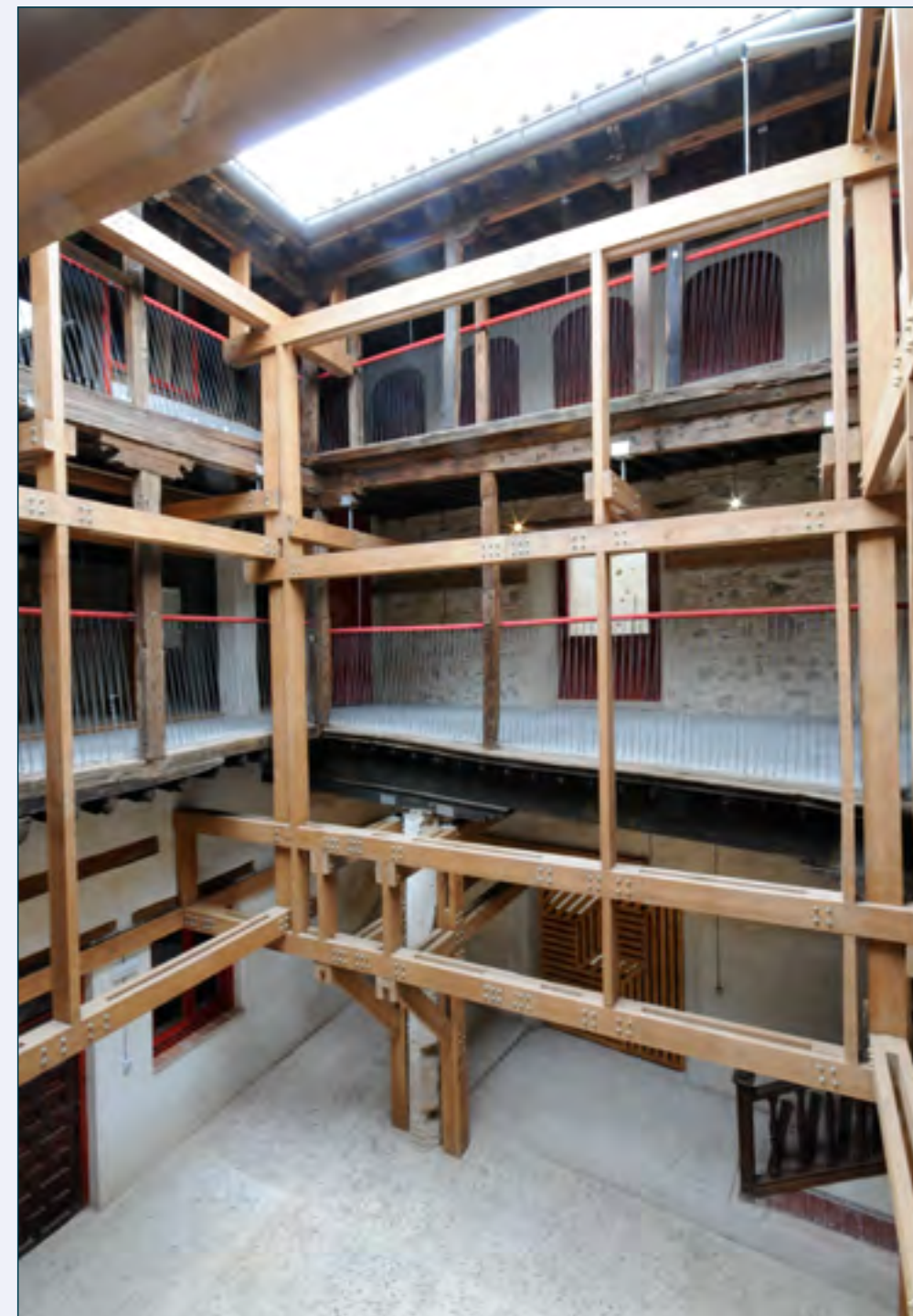
Fase III, instalaciones interiores y trabajos de restauración
