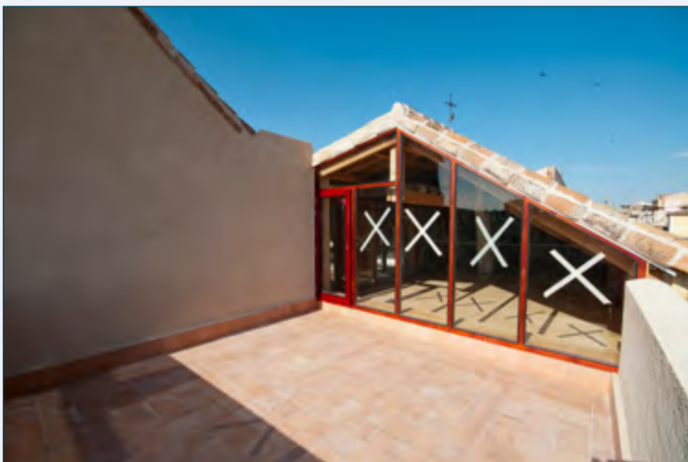
Rehabilitación Callejón de Menores, 12. Cerramientos e instalaciones
