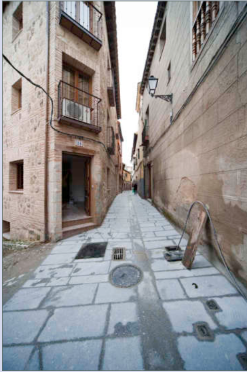
Calle de las Bulas en obras
