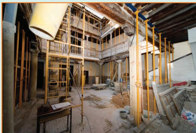
de dos zapatas en la planta baja del patio; Restauración de las vigas maestras del patio y de las molduras de remate del primer forjado; restauración y restitución de viguetas correspondientes a las plantas primera y segunda; restauración de solados de barro con olambrillas, y restauración de la azulejería del patio grande, mediante sistemas de paneles portantes.
