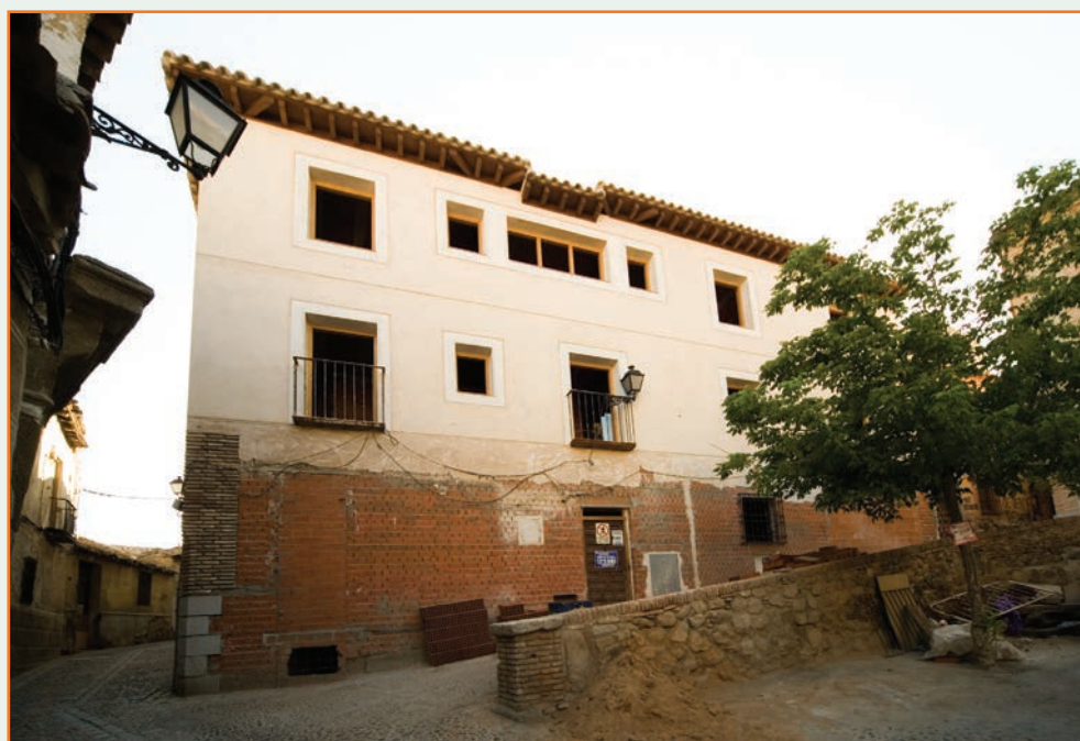
Calle de las Bulas, 29
