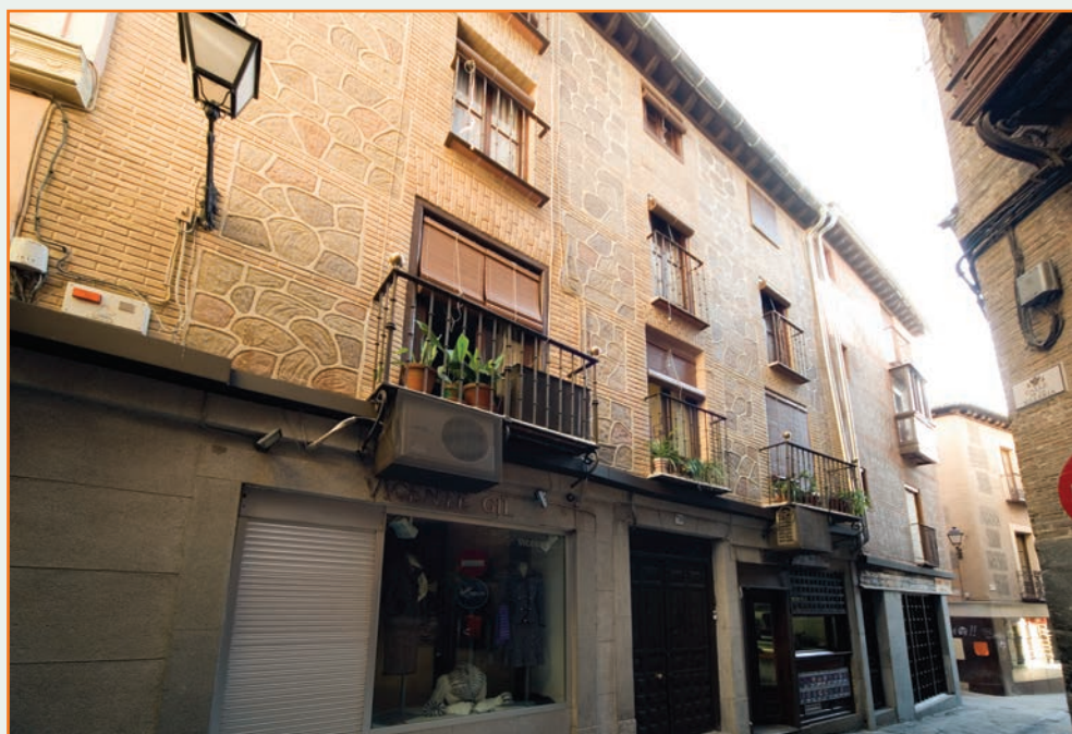
Calle Sillería después de la intervención
