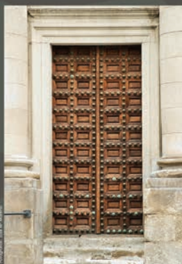
Restauración de puertas en la Iglesia de San Ildefonso
