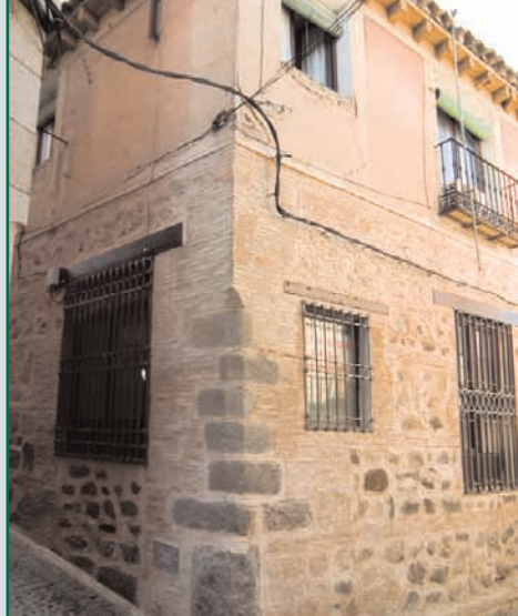
Esquina rehabilitada en Calle María Pacheco.
