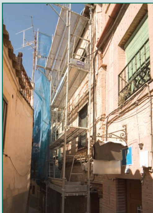
Obras en las Cuesta del Can N.º 1.
