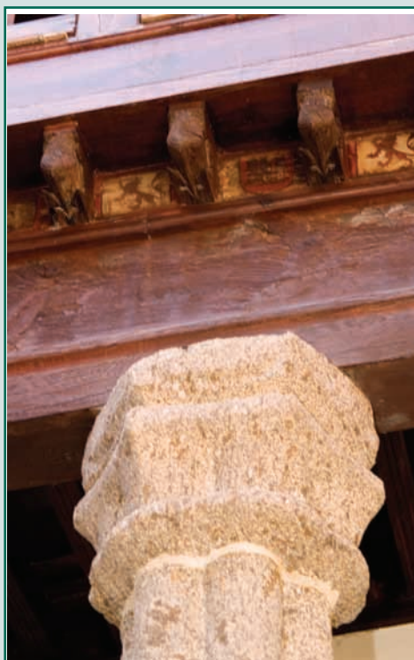
Detalle de Columna restaurada, Calle Merced N.º 6.
