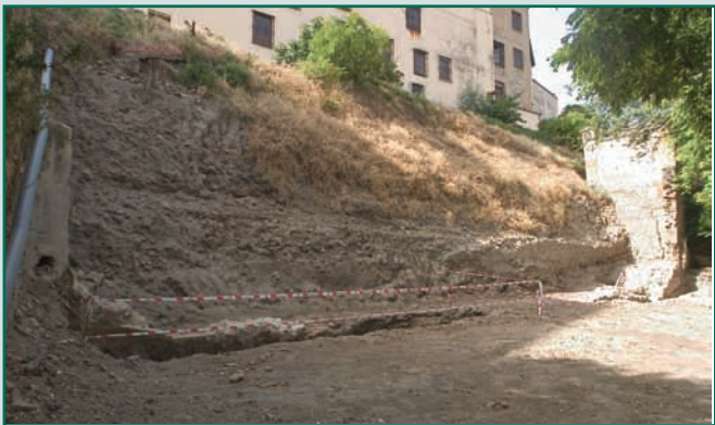
Intervención de Urgencias en el Convento de Santo Domingo el Real.
