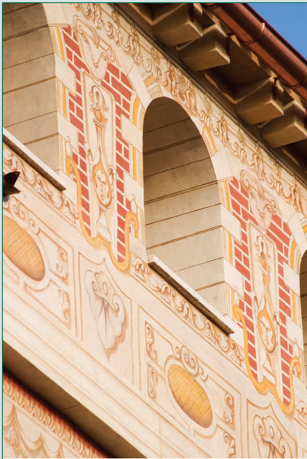
Detalle de la fachada de Calle Sillería N.º 18.
