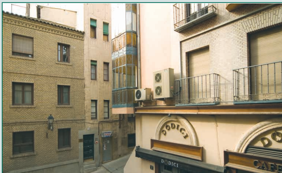
Retirada de cableado en la Plaza de la Campana.
