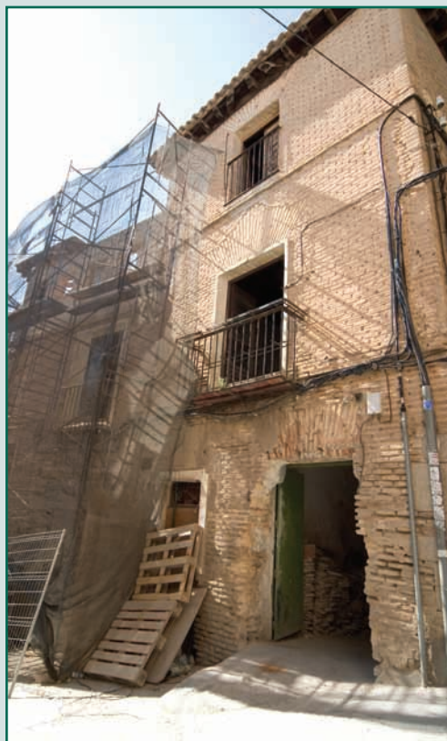
Obras en Calle Coliseo con Juan Labrador.
