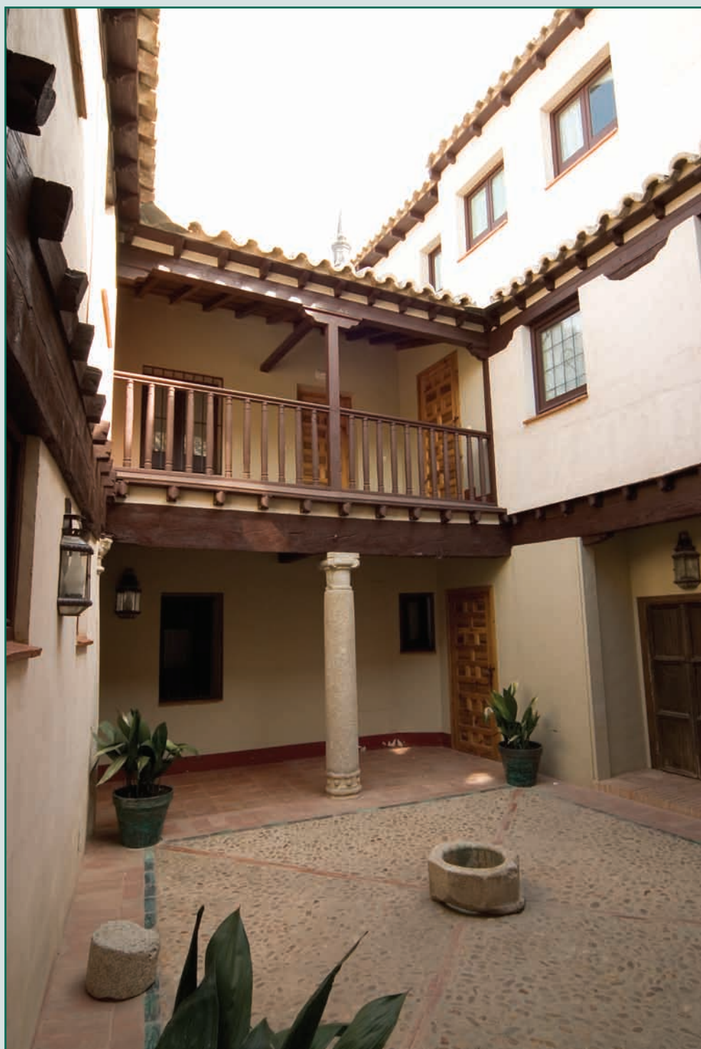
Patio rehabilitado en una vivienda en la Plaza del Seco N.º 5.
