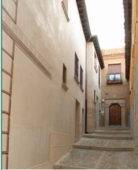
Rehabilitación integral de viviendas.
