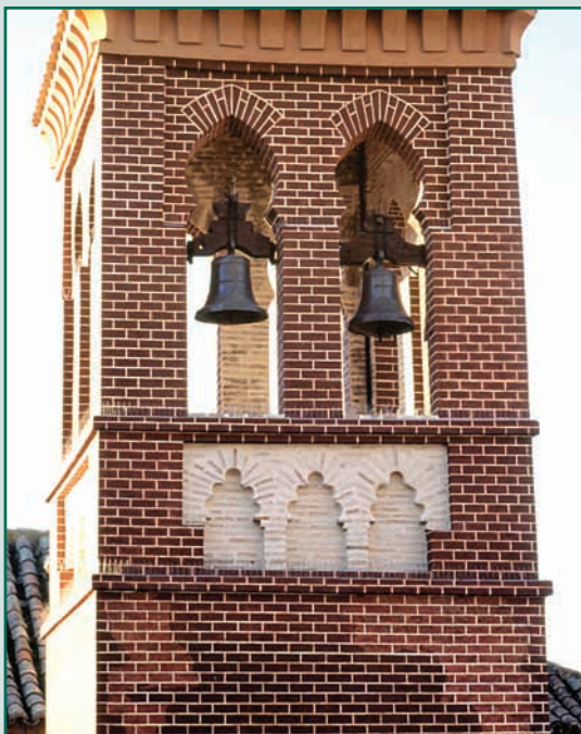
Detalle de la Torre de San Cipriano.
