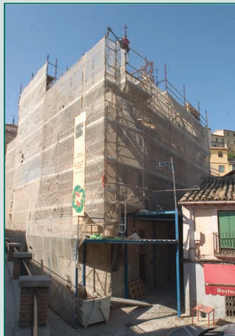
Obras de restauración en la Ermita de Nuestra Señora de la Estrella.
