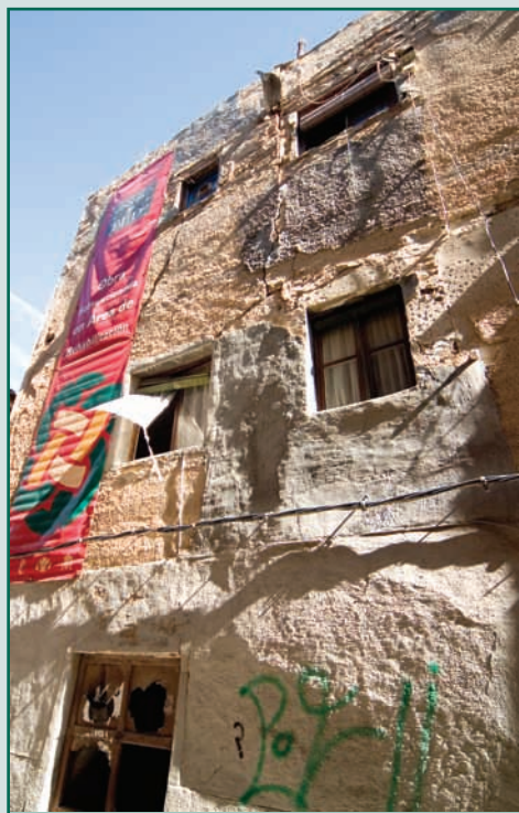
Actuación en Calle Las Bulas N.º 24.
