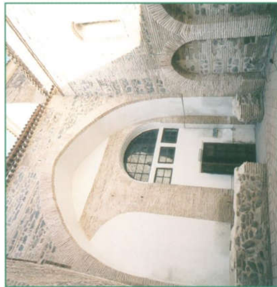
Una de las partes rehabilitadas en el Convento de Concepcionistas
