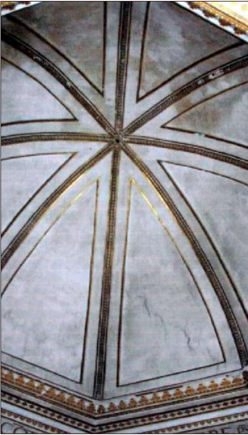
Capilla del palacio de Fernando de la Cerda: detalle de la plentería.
