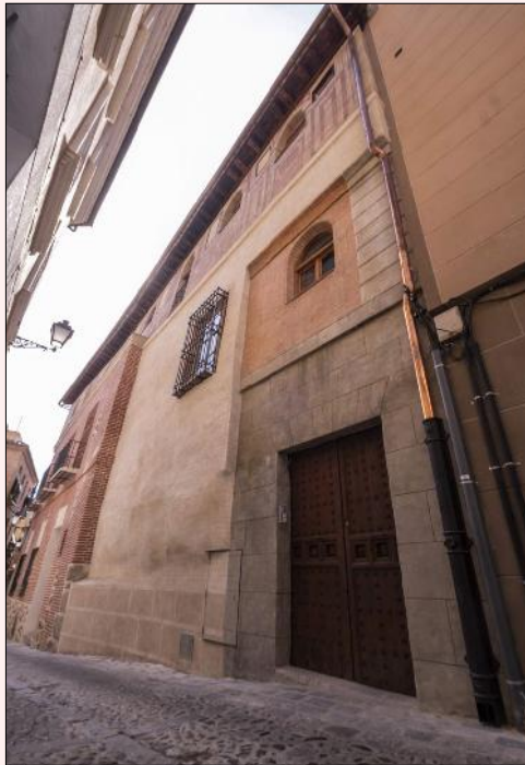
Acceso secundario y escalera interior, del siglo XVIII.
