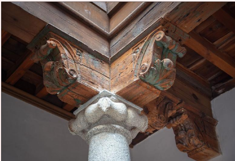
Patio de la calle de las Bulas, 8, con detalle de una de las zapatas 'en ese' tendida.
