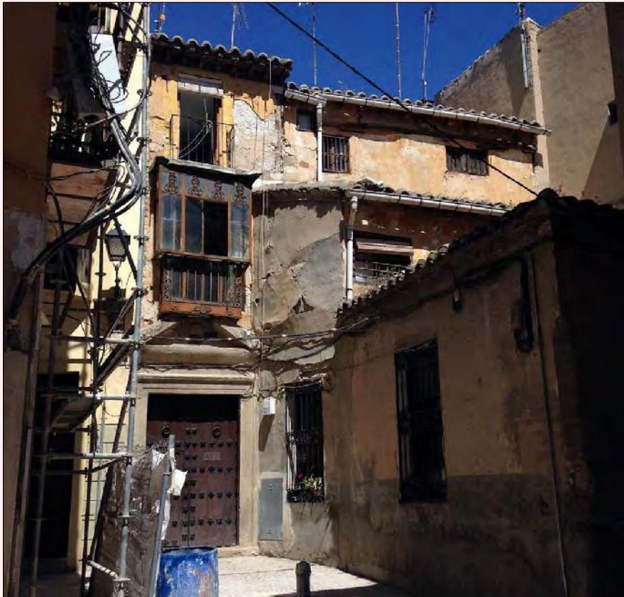
Aspecto del inmueble situado en la C./ Instituto, 21 antes de las obras.
