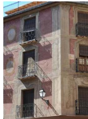
En la ejecución del proyecto, en el caso de la Torre de Santos Justo y Pastor, se eliminaron los restos del último revoco y se recuperó el estrato inferior mientras que en el edificio de calle Cadenas, se procedió a la consolidación y recuperación del último estrato y a la reconfiguración de las lagunas existentes.
